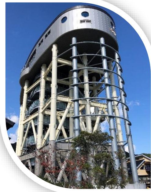
高知県黒潮町佐賀地区の津波避難タワー
